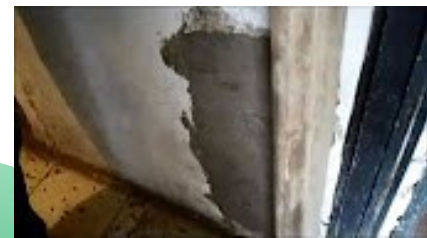
Pegar cemento nuevo a cemento viejo
