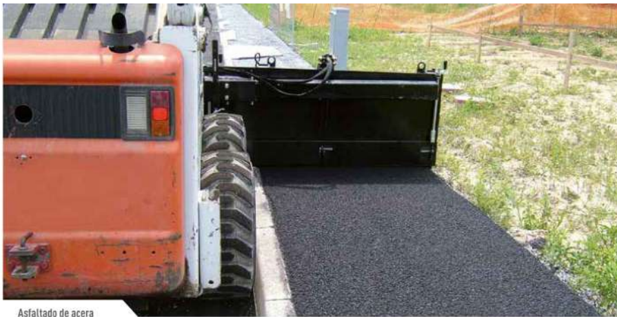
Asfaltado de acera
