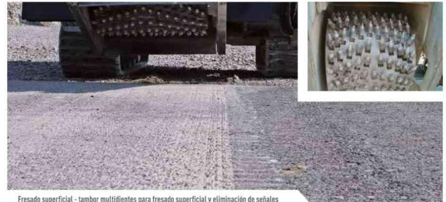
Fresado superficial - tambor multidentado para fresado superficial y eliminación de señales
