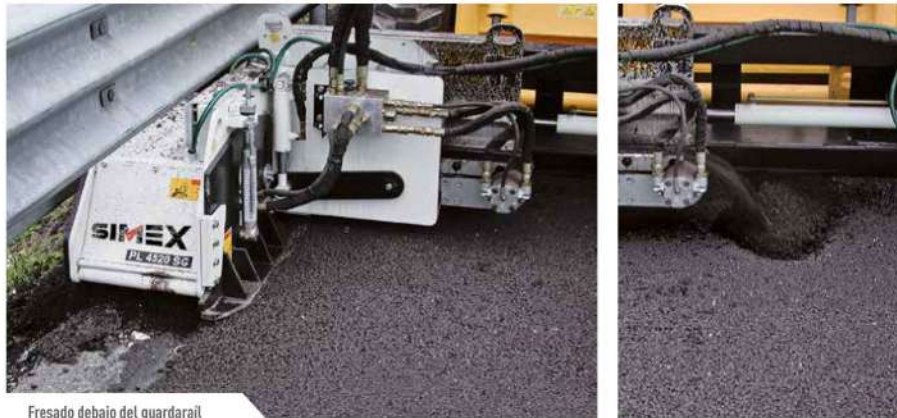
Fresado debajo del guardarrail
