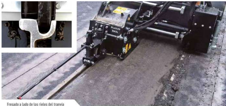
Fresado a lado de los rieles del tranvía
