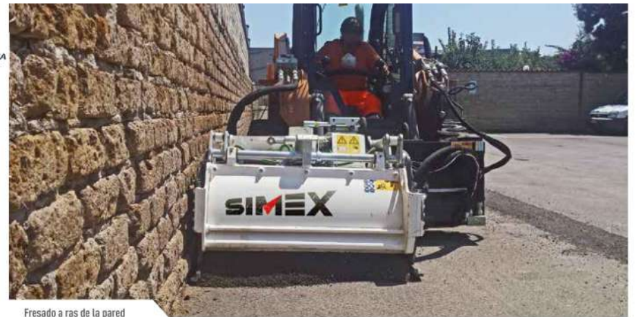
Fresado a ras de la pared
