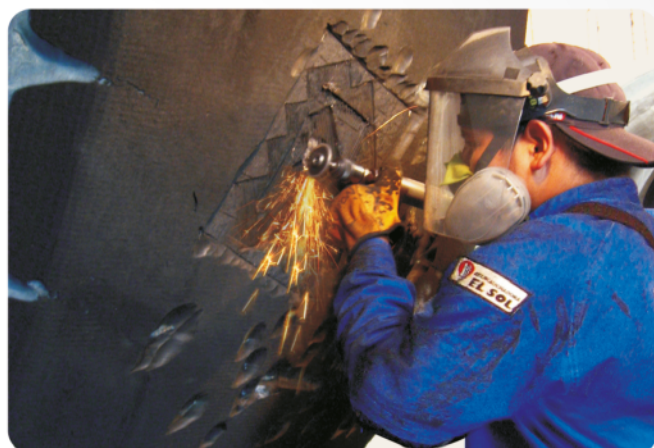
Operación de escariado y reparación con sistema de reemplazo de cuerdas de acero
