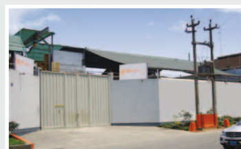
PLANTA 4 Transformadores de Distribución Jr. Luis Carranza 2174 - Lima 1
