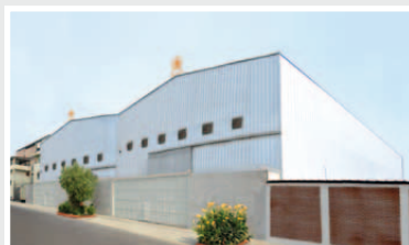
PLANTA 6 Transformadores de Potencia Jr. Luis Carranza 1905 - Lima 1
