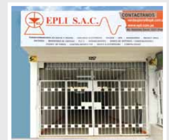
TIENDA COMERCIAL PIURA Av. Sanchez Cerro 1257 Urb. Club Grau
