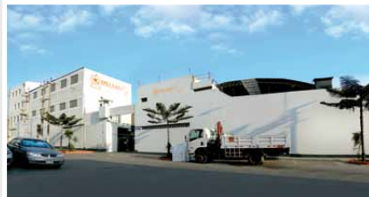
PLANTA 5 Metal Mecánica - Tableros y Celdas Jr. Luis Carranza 2089 - Lima 1
