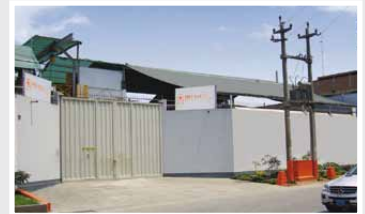
PLANTA 4 Transformadores de Distribución Jr. Luis Carranza 2174 - Lima 1
