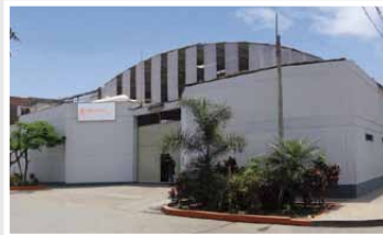
PLANTA 2 Transformadores de Distribución y Potencia Jr. Luis Carranza 2295 - Lima 1
