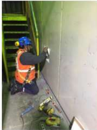
Instalación de difusores y rejillas, incluyendo pases en sala de control y resanes.
