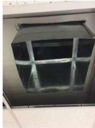
Instalación de difusores y rejillas, incluyendo pases en sala de control y resanes.
