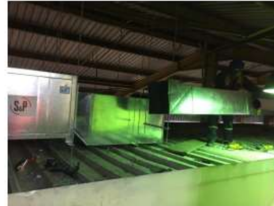
Instalación de inyector centrífugo, extractor centrífugo y caja de filtros, todo soportado desde las vigas superiores
