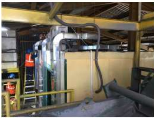
Armado e instalación de ductería
