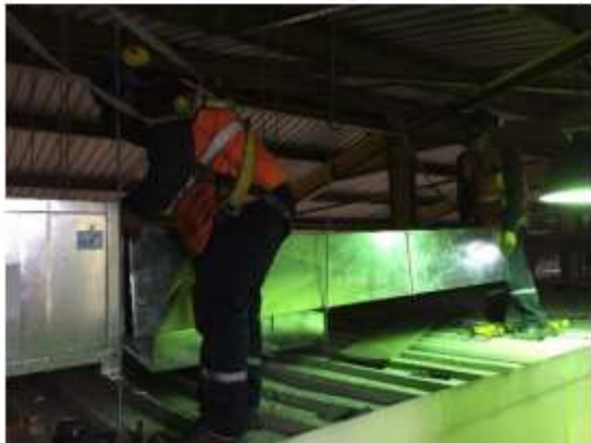
Instalación de inyector centrífugo, extractor centrífugo y caja de filtros, todo soportado desde las vigas superiores
