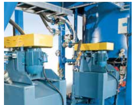
El sistema SLR de transferencia de pulpa emplea bombas verticales Sepro
