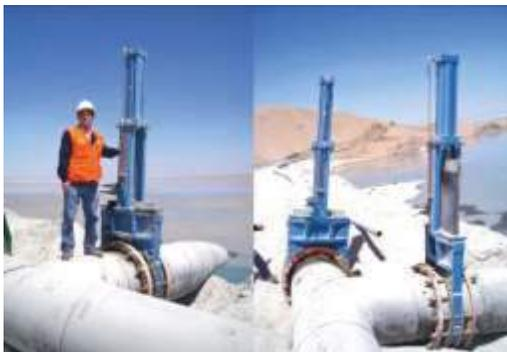
Válvulas de 30" con accionamiento hidráulico instaladas en zona de relaves QUEBRADA HONDA- SOUTHERN PERU
